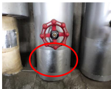
遮熱シートのテスト施工
